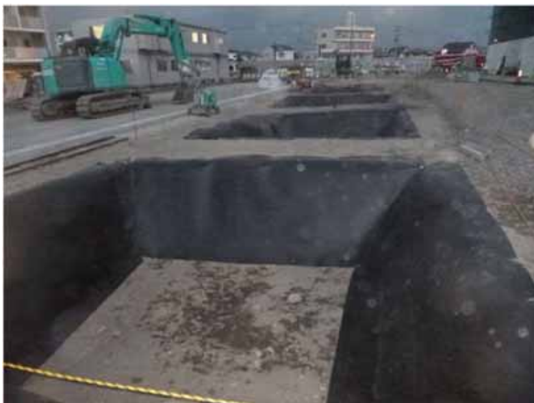
写真 9.5-1 外構汚染土壌掘削，遮水シート設置の状況（平成 26 年 1 月撮影）
