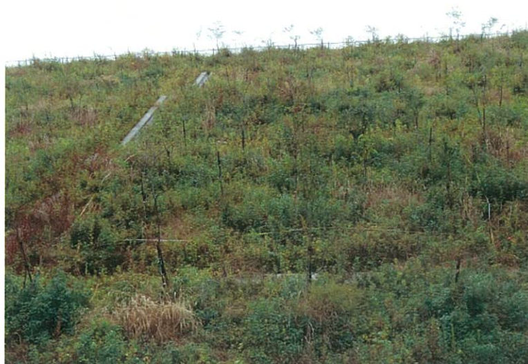
写真 5-1 法面の状況（平成 25 年 10 月 24 日撮影）
