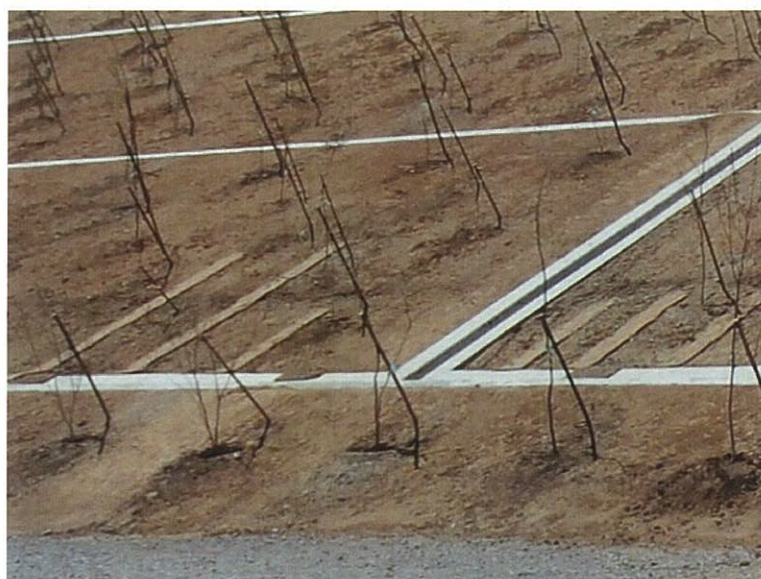
写真 8-6-3 ヤシマットの敷設状況 (平成 25 年 4 月 13 日撮影、拡大後トリミング)
