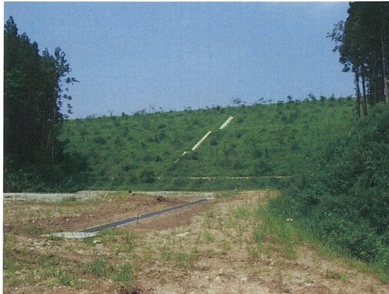
写真 8-6-4 盛土法面の状況 (平成 25 年 8 月 10 日撮影)
