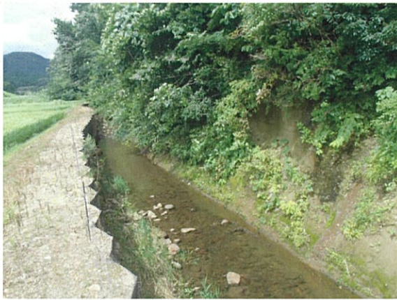
C. 大型土嚢で整備された区間（右岸）
