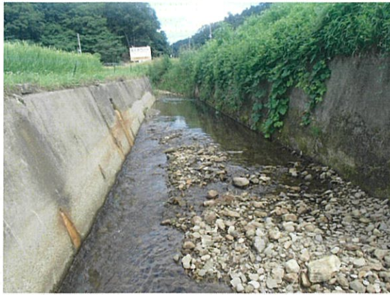
A. コンクリートで整備された区間
