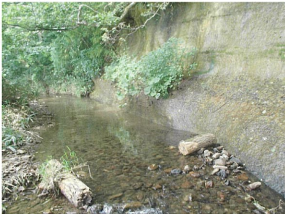
E. 岩盤の露出した区間（左岸）
