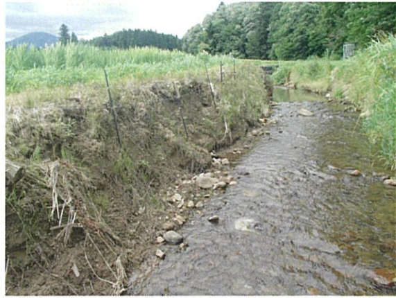
B. 法面の露出した一部区間（右岸）
