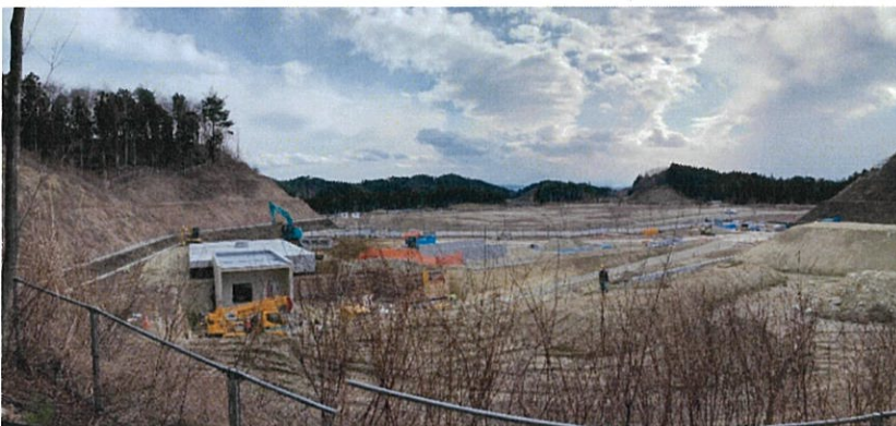
写真 5-2 第 2 期事業区域 2 工区の状況（令和 5 年 3 月 15 日撮影）
