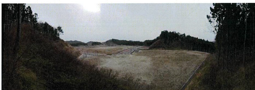
写真 5-2 第 2 期事業区域 2 工区の状況（令和 3 年 12 月 13 日撮影）
