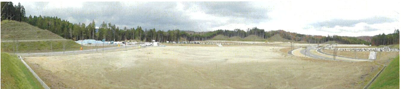
写真 6-1 第 2 期事業区域の状況 (平成 28 年 11 月 17 日撮影)
