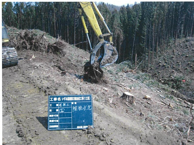
写真 8-6-1 原地盤の処理(除根状況)(平成 24 年 4 月 5 日撮影)
