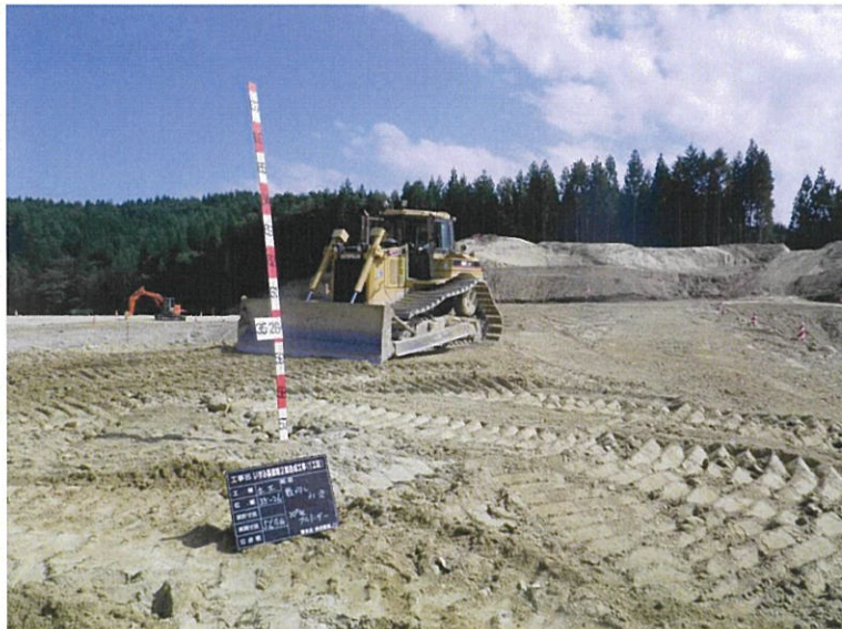
写真 8-6-4 敷均し(平成 24 年 9 月 5 日撮影)
