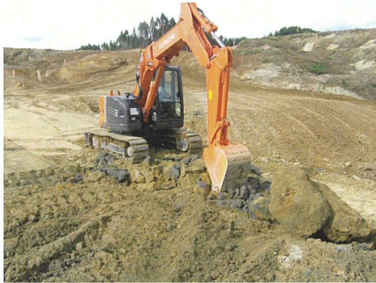
写真 8-6-3 岩塊の小割(平成 24 年 9 月 5 日撮影)
