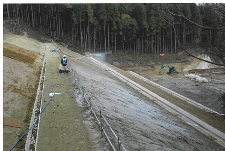
写真 8-6-7 法面保護剤散布(平成 24 年 11 月 22 日撮影)
