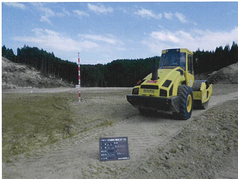
写真 8-6-5 締固め(平成 24 年 9 月 18 日撮影)
