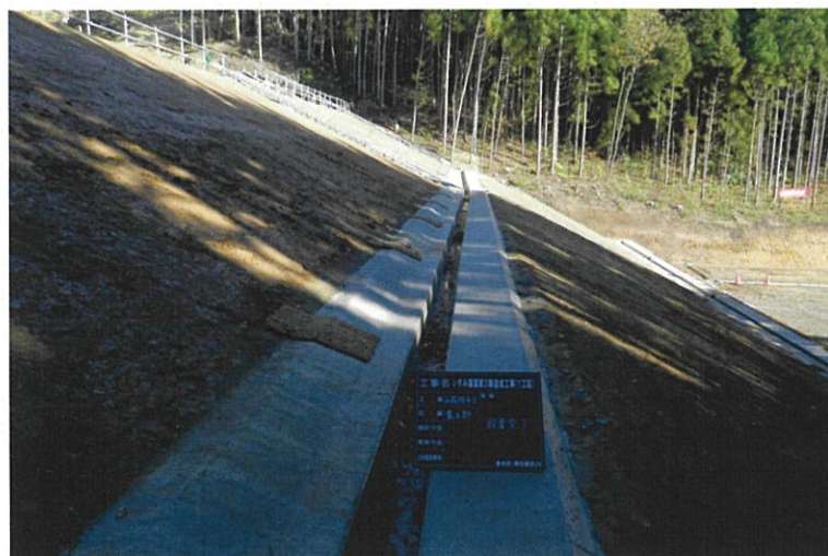
写真 8-6-6 小段排水工(平成 24 年 11 月 20 日撮影)
