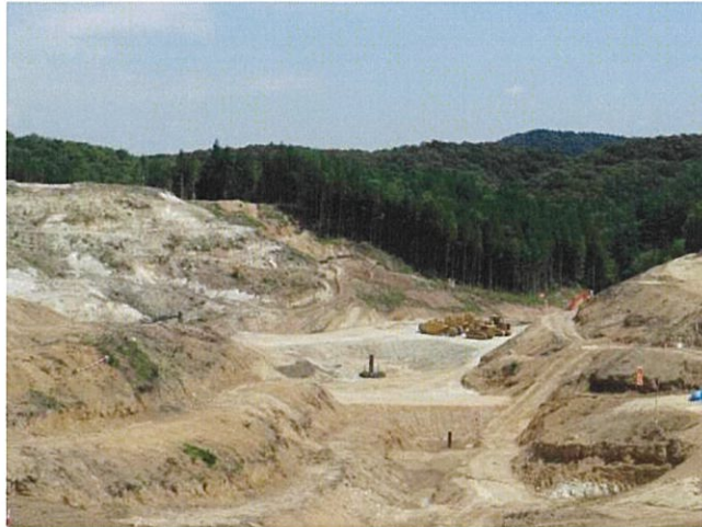
写真 7-6 沈砂池の設置状況 (平成 24 年 9 月 13 日撮影)
