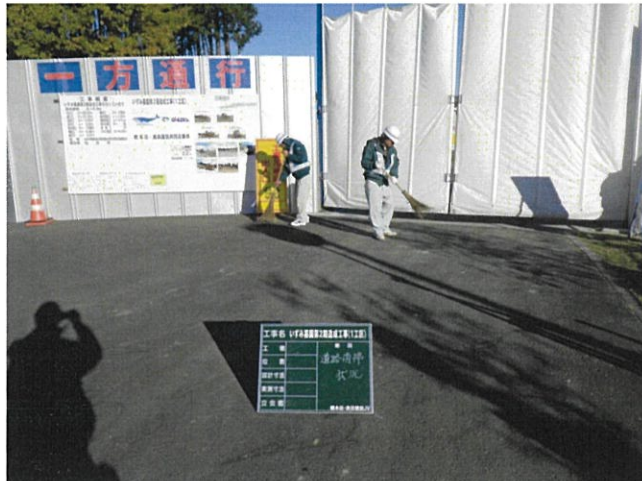
写真 7-4 出入口の清掃状況(平成 24 年 11 月 21 日撮影)
