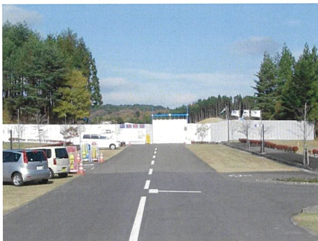
写真 7-1 仮囲いの設置状況(平成 24 年 11 月 19 日撮影)
