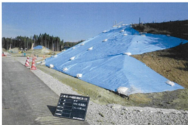
写真 7-5 シート被覆の状況(平成 24 年 11 月 19 日撮影)
