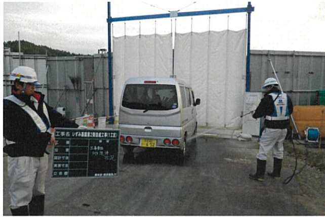
写真 7-3 タイヤ洗浄状況(平成 24 年 11 月 19 日撮影)
