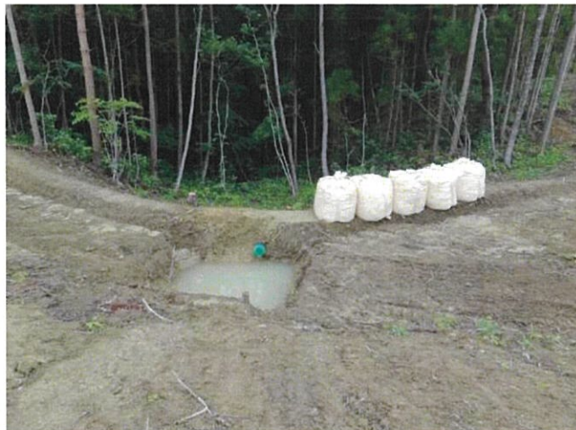
写真 7-8 仮設沈砂池の設置状況 (平成 24 年 6 月 14 日撮影)
