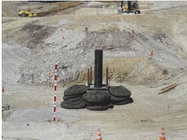
写真 7-7 堅集水柵及びチップ袋の設置状況 (平成 24 年 8 月 23 日撮影)
