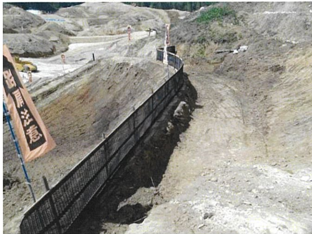
写真 7-9 土砂流出防止柵の設置状況(平成 24 年 8 月 23 日撮影)
