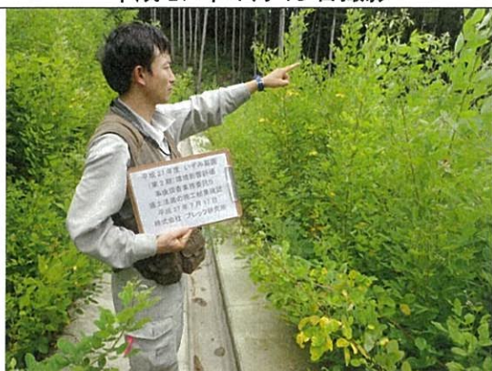
盛土法面の施工結果確認 平成 27 年 7 月 17 日撮影
