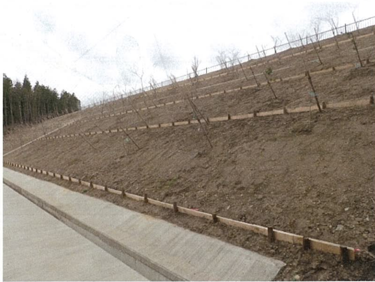
写真 7-4 表土施工後の状況：近景（平成 27 年 4 月 13 日撮影）
