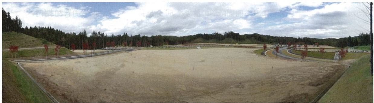
写真 6-1 第 2 期事業区域の状況 (平成 27 年 10 月 13 日撮影)
