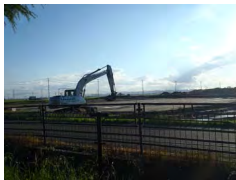
B工区-②ブロック盛土工事
