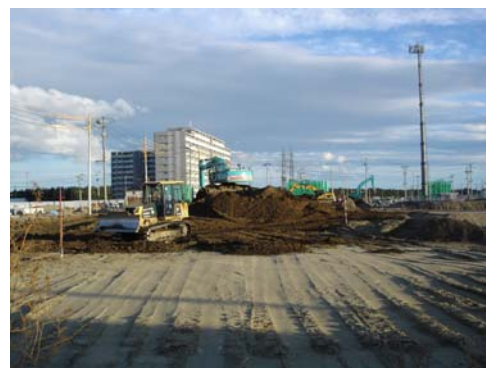
図 5-22 屋敷林跡地周辺の造成 (平成 25 年 11 月 28 日撮影)
