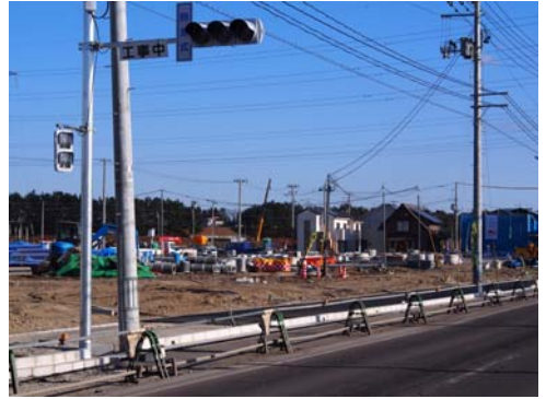
図 5-24 県道荒浜原町線沿いの 埋設管工事準備状況 (平成 25 年 10 月 7 日撮影)
