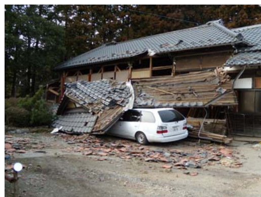
図 5-9 屋敷林所有者の家屋の倒壊 (平成 23 年 3 月 27 日撮影)
