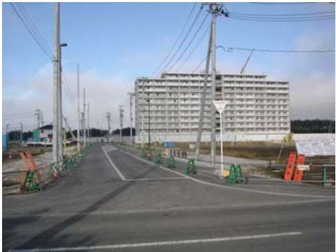
図 5-23 復興公営住宅と都市計画 道路荒井東線の車道舗装 (平成 25 年 10 月 7 日撮影)
