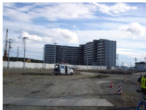
図 5-21 復興公営住宅 (平成 25 年 11 月 28 日撮影)
