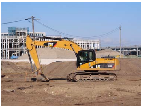
図 5-19 地下鉄駅舎前の造成工事 (平成 26 年 2 月 1 日撮影)
