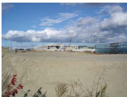
図 5-18 北部の地下鉄車両基地西側の造成 (平成 25 年 11 月 28 日撮影)
