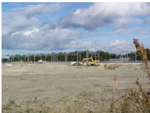
図 5-17 北部の地下鉄車両基地西側の造成 (平成 25 年 11 月 28 日撮影)
