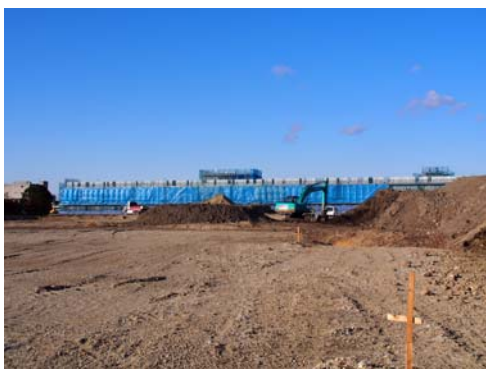
図 5-20 地下鉄駅舎前のプレロード転用工事 (平成 26 年 2 月 1 日撮影)
