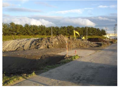
図 5-22 雨水貯留施設の掘削工事 (平成 25 年 11 月 28 日撮影)
