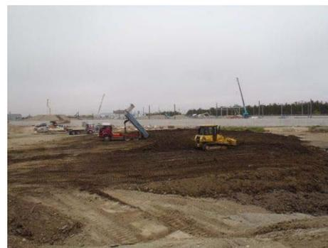
図 6.5-2 敷均し締固め状況 (2)
