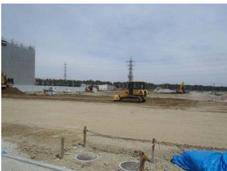
図 6.5-1 敷均し締固め状況 (1)
