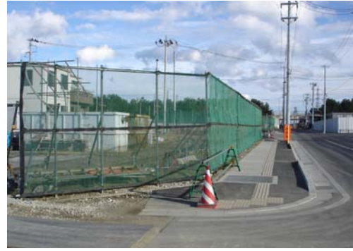
図 5-16 防塵ネット設置状況 (平成 25 年 11 月 28 日)
