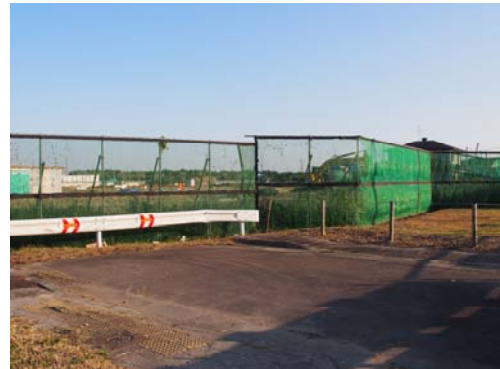
図 5-18 防塵ネット設置状況 (平成 26 年 10 月 24 日)
