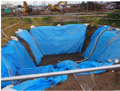
図 5-21 南部造成区域の釜場 (平成 26 年 5 月 22 日撮影)
