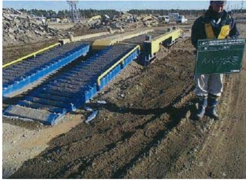
図 5-15 タイヤの泥落とし装置（スパツ）の設置 (平成 25 年 11 月 28 日)
