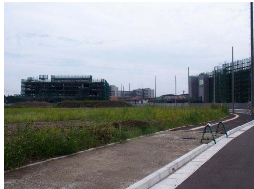
図 4.1-14 事業区域北部の介護老人保健施設 と集合住宅（建築中） （平成 27 年 8 月 12 日撮影）
