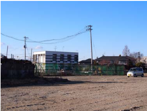
図 5-17 防塵ネット設置状況 (平成 26 年 1 月 29 日)
