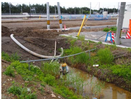
図 5-19 北部造成区域の釜場 (平成 26 年 5 月 22 日撮影)
