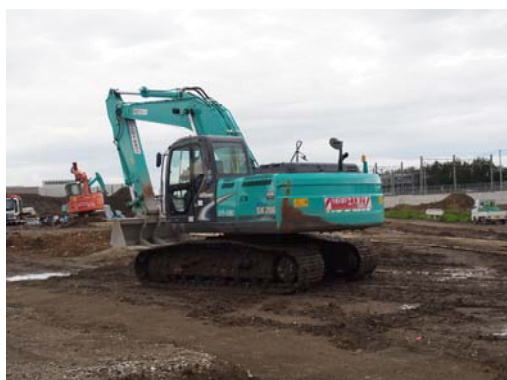
図 5-3 排出ガス適合・低騒音型建設機械 (平成 26 年 5 月 22 日)
