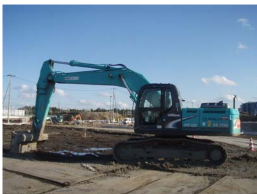
図 5-5 排出ガス適合・低騒音型建設機械 (平成 27 年 2 月 10 日)
