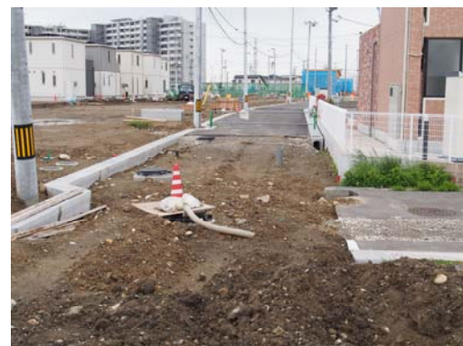
図 5-20 ポンプにより釜場から雨水管渠へ放流 (平成 26 年 5 月 22 日撮影)
