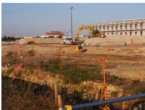
図 5-9 家屋近傍で小型トラックによる運搬土工 (平成 26 年 10 月 24 日)
