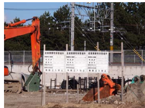
図 5-30 現場内廃棄物保管場所 (平成 27 年 8 月 12 日撮影)
