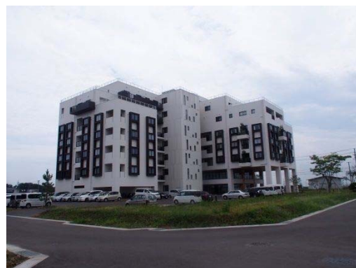
図 4.1-10 事業区域南部の福祉施設 (平成 27 年 8 月 12 日撮影)
