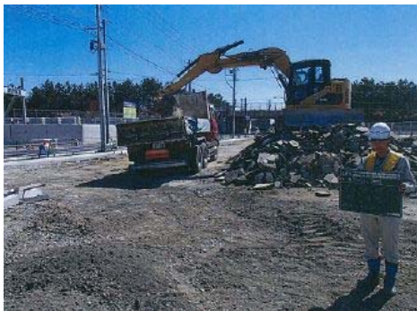
図 5-27 コンクリート殻積込状況 (平成 22 年 11 月 9 日撮影)
