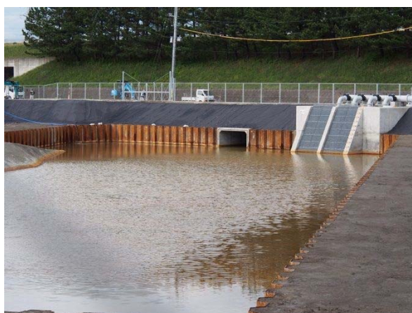
図 4.3-1 完成した雨水貯留施設 (平成26年5月22日撮影)
