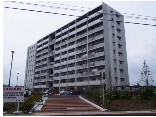
図 4.1-12 入居された復興公営住宅（第二期） （平成 27 年 8 月 12 日撮影）
