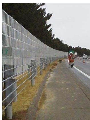
図 4.2-3 高速道路遮音壁完成写真 （高速道路側） （平成27年3月5日撮影）
