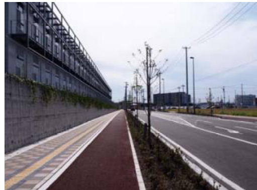
写真 4-6 都市計画道路沿いの地下鉄車両基地の壁面 (平成 28 年 10 月 13 日撮影)
