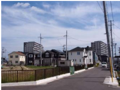
写真 4-19 市営住宅 1 期棟と集会所 (平成 28 年 10 月 13 日撮影)
