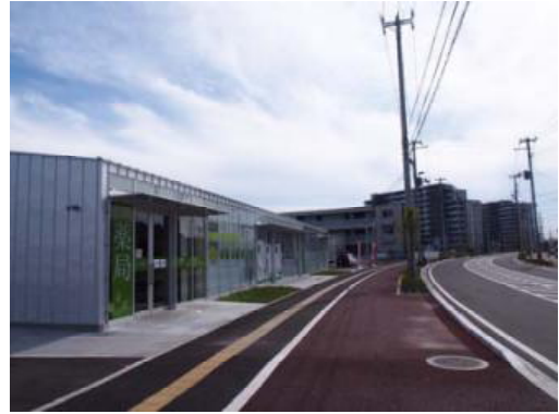
写真 4-10 都市計画道路荒井東線沿い業務施設 (平成 28 年 10 月 13 日撮影)
