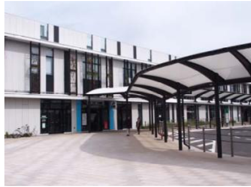
写真 4-2 地下鉄東西線の荒井駅 (平成 28 年 10 月 13 日撮影)
