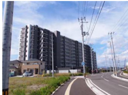
写真 4-8 10階建マンション(122戸) (平成 28 年 10 月 13 日撮影)
