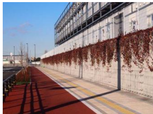
写真 5-6 地下鉄車両基地の壁面緑化と歩道の透水性舗装 (平成 29 年 12 月 21 日撮影)
