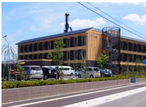
写真 5-7 介護老人保健施設の外周緑化 (平成 28 年 7 月 11 日撮影)
