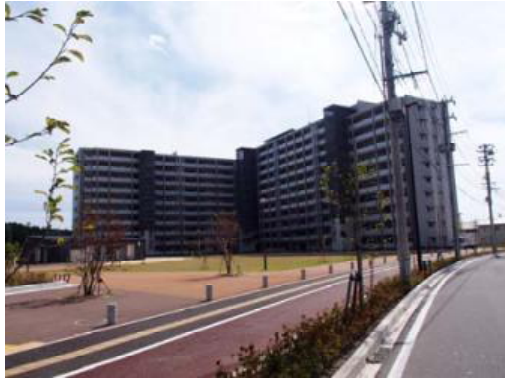
写真 4-17 市営住宅 1 期棟と集会所 (平成 28 年 10 月 13 日撮影)
