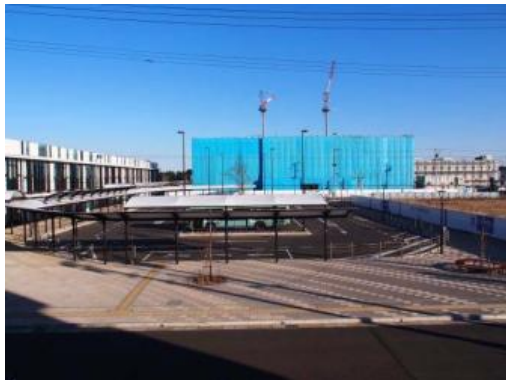
写真 5-3 駅前広場歩道の透水性舗装 (平成 29 年 12 月 21 日撮影)
