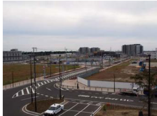
写真 4-4 荒井駅屋上より事業区域南方向 (平成 28 年 10 月 13 日撮影)
