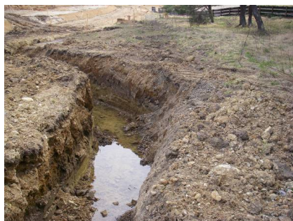
仮設水路 (平成 22 年 4 月 21 日撮影)
