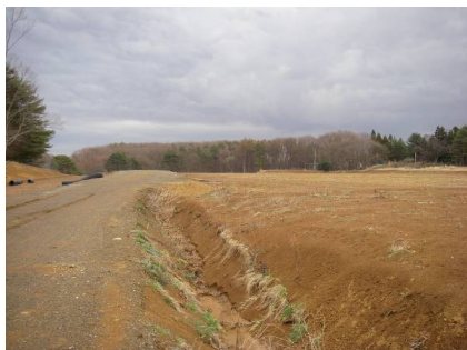
仮設水路 (平成 22 年 4 月 13 日撮影)
