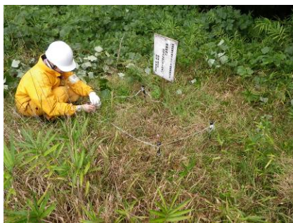
ロープ柵の補修作業 (平成22年9月27日撮影)
