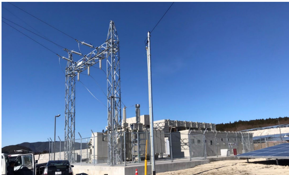
図 2.2-28 特高変電所のイメージ (写真)
