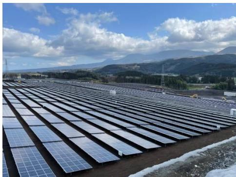
ソーラーパネルの設置状況
