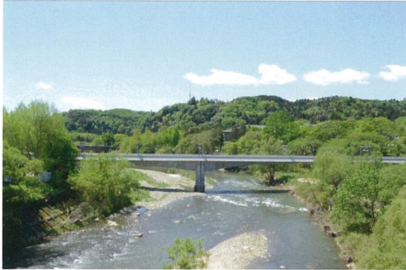
写真 4-2.1 広瀬川橋りょう（仲ノ瀬橋からの眺望）
