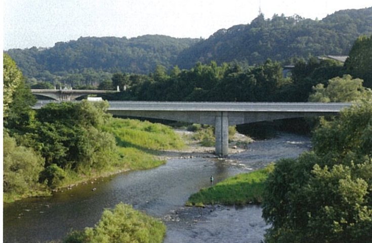
写真 4-1 広瀬川橋りょう（仲ノ瀬橋からの眺望）
