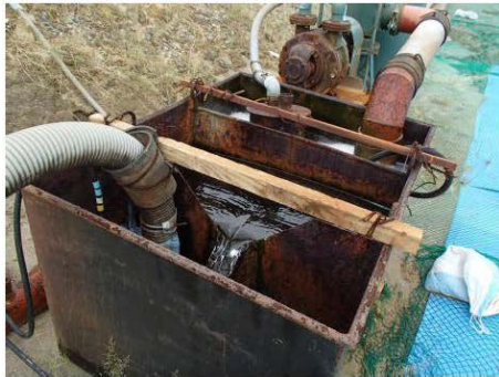
地下水位低下装置
