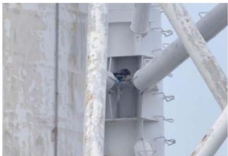
営巣地（既設煙突）内の成鳥 （平成 25 年 4 月 26 日撮影）
