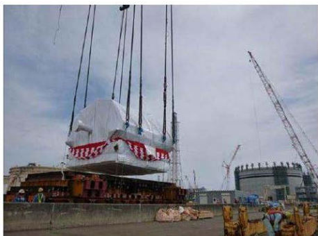
3-1号タービン搬入 (平成26年9月)
