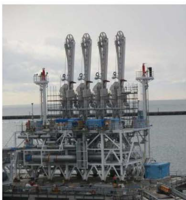
LNG受入設備据付 (平成26年12月)
