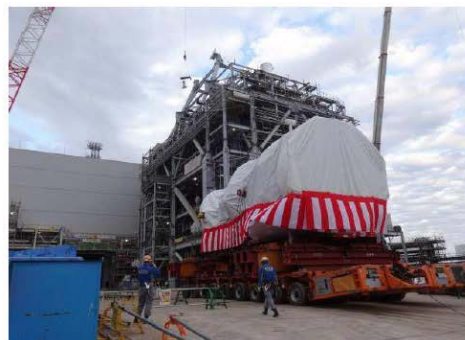
3-2号タービン搬入 (平成26年11月)
