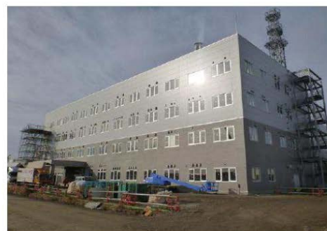
サービスビル新築 (平成26年12月)
