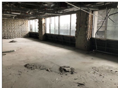
病院本棟 7F 腰壁ケイカル板 アスベスト撤去
