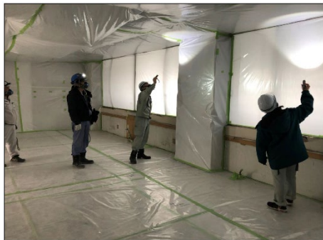
撤去前養生検査
