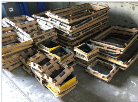
病院本棟 PHF 設備ダクトジョイント アスベスト撤去
