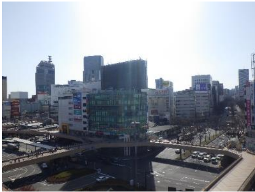
③駅屋上からの状況(西口)
