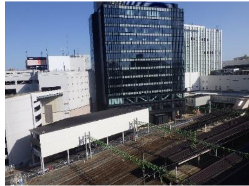
④駅屋上からの状況(東口)
