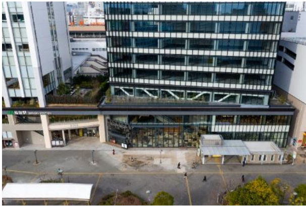
業務施設屋上（東側上空から西方向）
