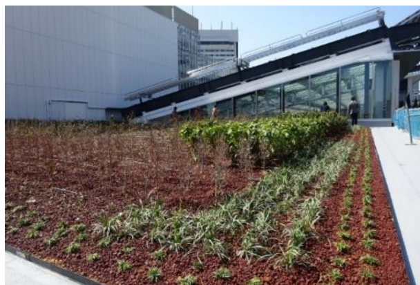
東西自由通路屋根部分
