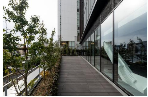
業務施設屋上（南東側から北西方向）
