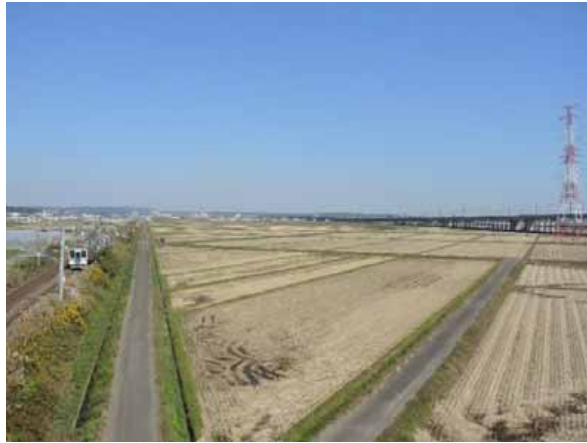
国道 4 号より計画地をのぞむ
