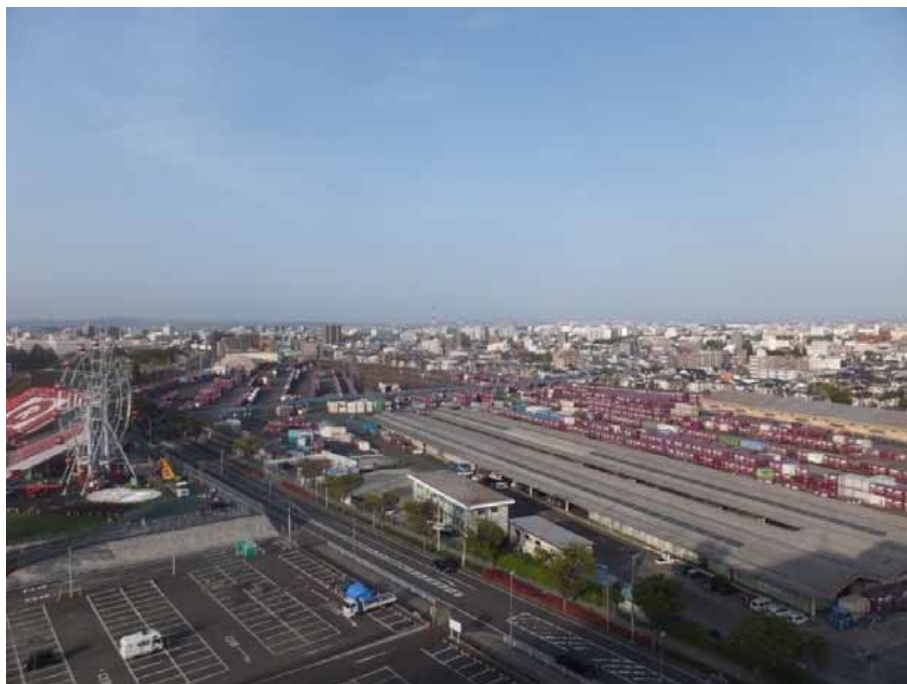
写真 1-3 現駅の状況 (H28.4.25 撮影)
