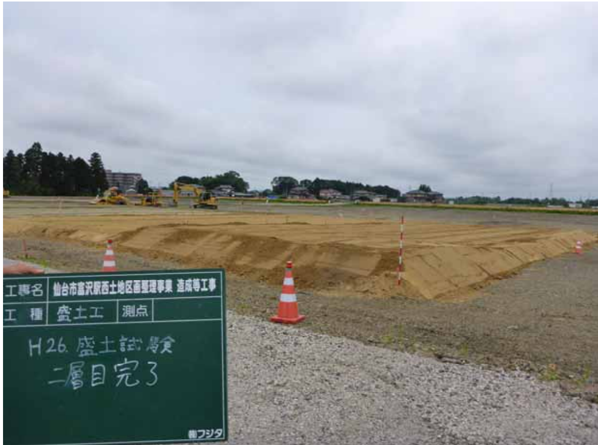
写真4.6-1(2) 試験盛土の状況（2層目）
