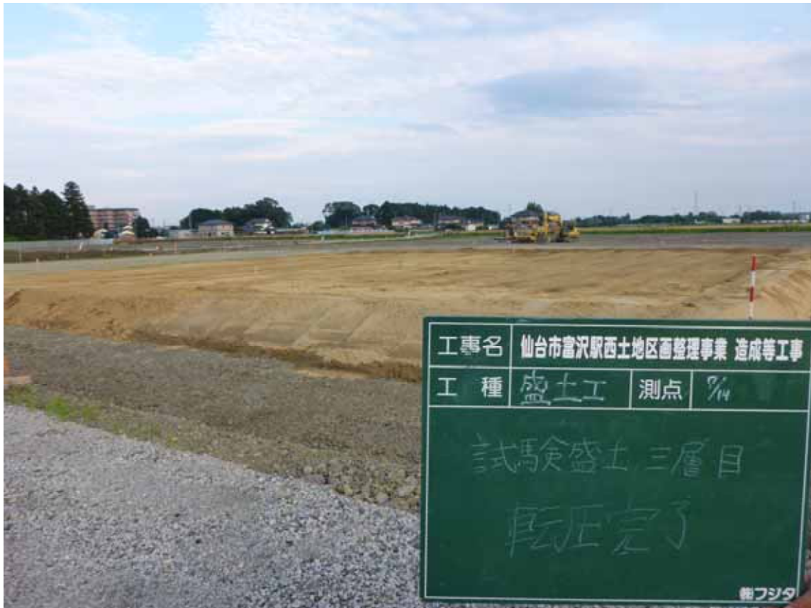
写真4.6-1(3) 試験盛土の状況（3層目）
