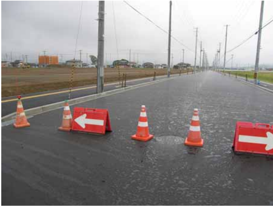
写真4.5-1(2) 2工区の完成状況
