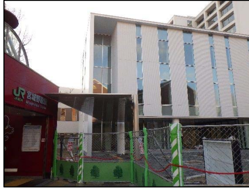
写真 1.4-1 キャノピー設置状況(平成 31 年 1 月 25 日撮影)
