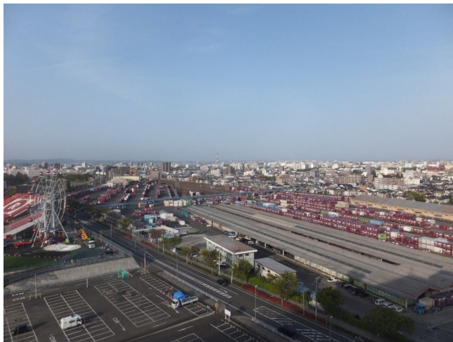
写真 1.6-1 現駅の状況 (H28. 4. 25 撮影)
