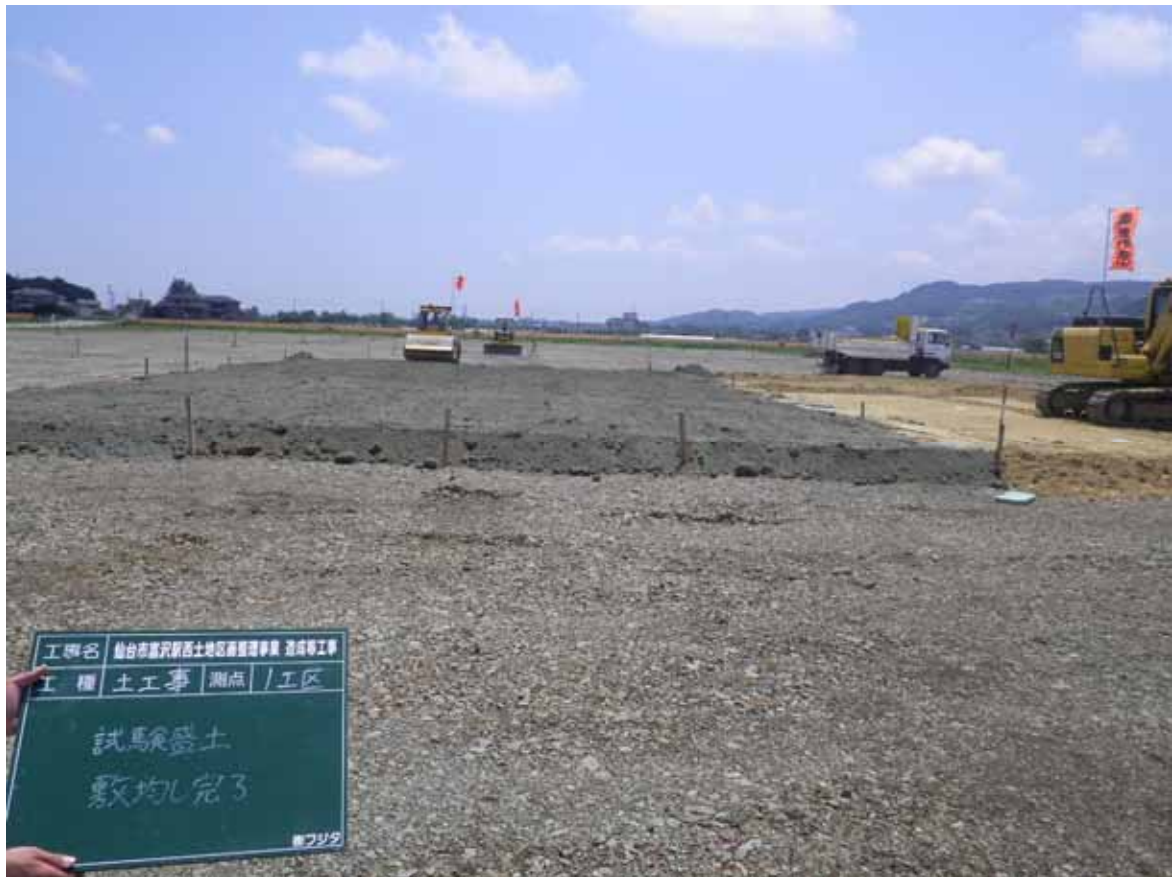
写真4.6-1(1) 試験盛土の状況（1層目）
