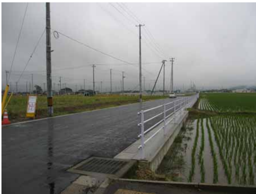
写真4.5-1(1) 1工区の完成状況
