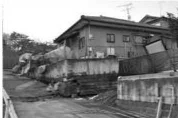
<宅地被害（青葉区折立）>
