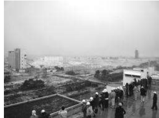
< 南蒲生浄化センター（宮城野区蒲生） >
