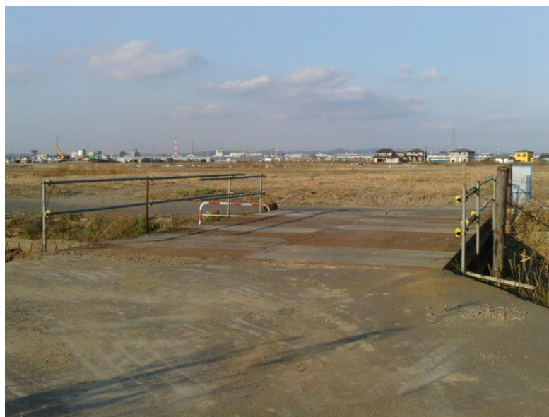
写真 6-3-6 仮設橋（蒲生搬入場）
