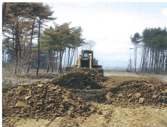
写真 6-3-4 搬入場造成施工時(蒲生搬入場)
