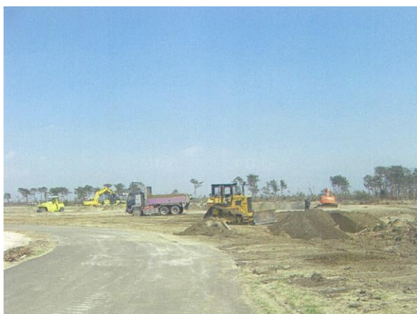
写真 6-3-3 搬入場造成施工時(蒲生搬入場)
