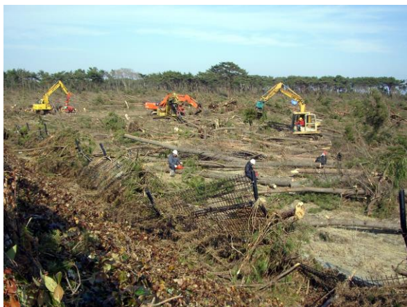
写真 6-3-1 倒木・流木撤去業務施工時 (荒浜搬入場)
