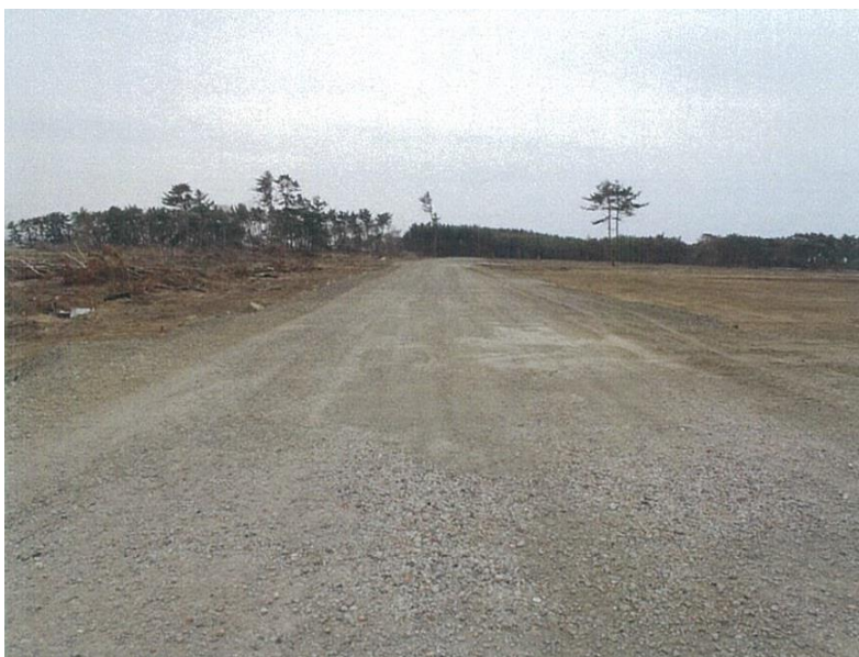
写真 6-3-5 搬入場内通路（荒浜搬入場）
