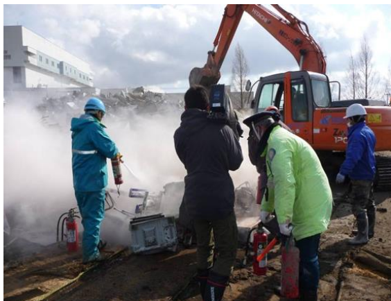
写真 4-2-7 消火器による消火
