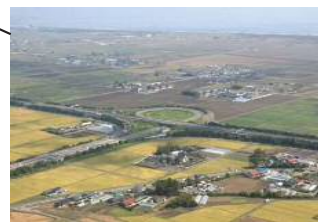
市街地への津波の浸入を防いだ高さ6mの高速道路（仙台東部道路）
