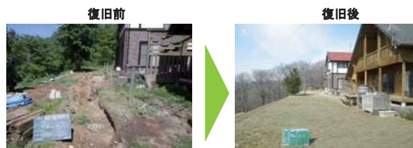
内陸丘陵部の宅地被害と復旧状況（青葉区高野原一丁目）
