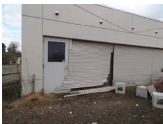
⑩冒険広場 倉庫
