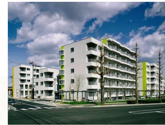
①鶴ヶ谷第一市営住宅（第一工区）
