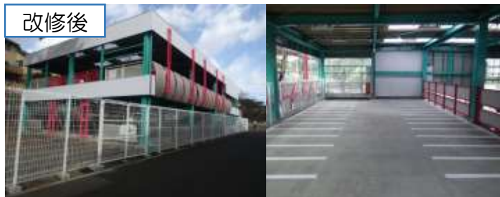
図19 黒松駅駐輪場 大規模改修
