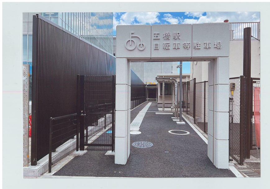
図20 五橋駅自転車等駐車場
