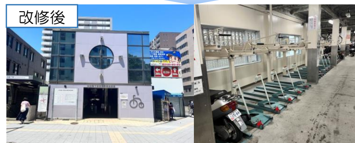
図21 北四番丁駅駐輪場改修
