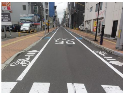
▲施策12 ゾーン30のピクトグラム設置事例 (青葉区大町二丁目)
