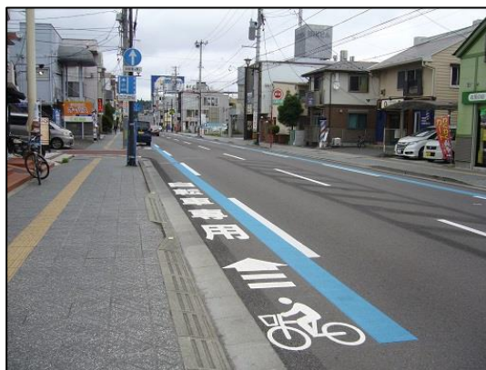
【写真 3-3】青系色の自転車専用通行帯整備事例 （市道宮町通線）
