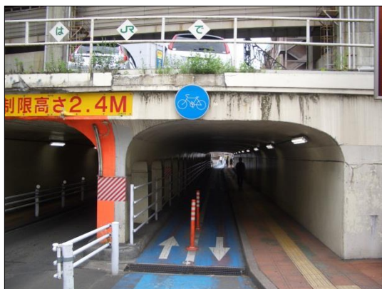
【写真 3-1】青系色の自転車道整備事例 （市道中央一丁目西宮城野線）
