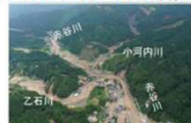
④赤谷川における 土砂・洪水氾濫及び流木による被害 (福岡県朝倉市)
