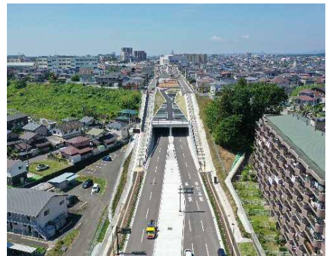
【都市計画道路宮沢根白石線】 （浦田工区）
