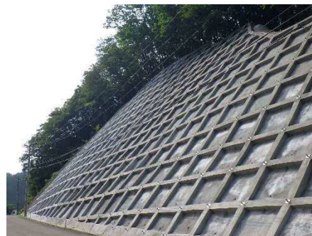
【道路法面の防災対策】
