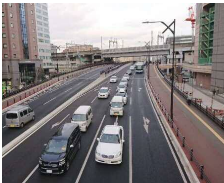
【都市計画道路元寺小路福室線】 （宮城野橋工区）
