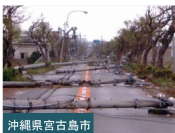
災害時の救助活動を妨げる電柱
