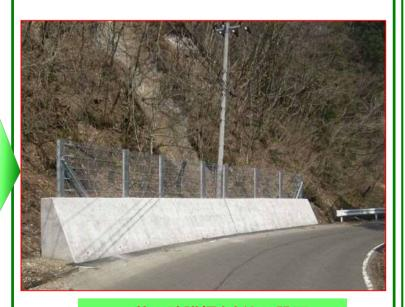
▲落石防護柵を新たに設置
