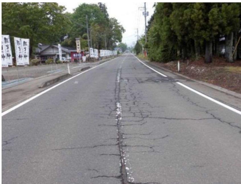
経年劣化により、舗装面のひび割れが発生し、走行性が低下している。
