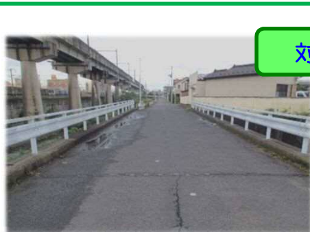
▲防護柵の劣化など安全性の低下
