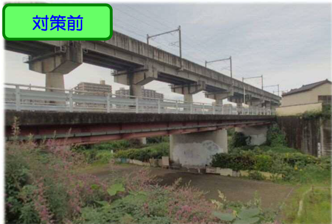
▲主桁のサビなど劣化による機能・耐久性の低下
