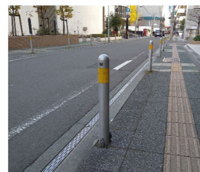
防護柵等の設置（ボラード）
