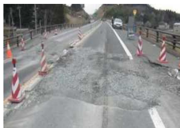
写真 碎石での応急措置
