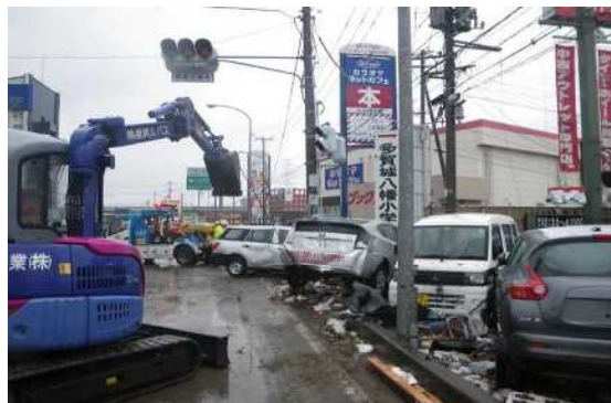
写真 災害時の撤去作業状況
