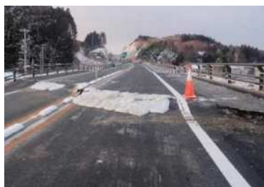
写真 土嚢での応急措置
