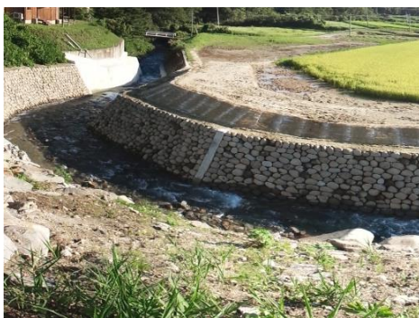
空積み護岸の整備による 河川周辺環境への配慮
