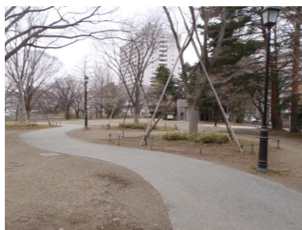
公園に整備された透水性舗装 (西公園)
