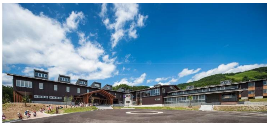
地域産材を活用した木造建築の事例（泉岳自然ふれあい館）
