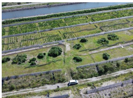
海岸防災林の植林状況 (令和2年9月撮影)
