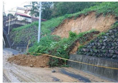
本市における土砂災害（かけ崩れ）の被害 （令和元年東日本台風）
